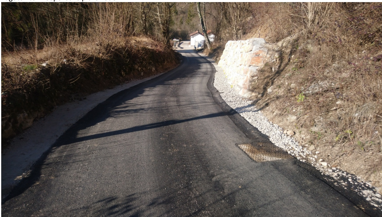
Slika: vodovod Podstenjšek
